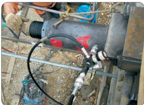
Cilindro forato a semplice effetto con ghiera di sicurezza CRM 60/260 GS per operazioni di lancio ponti.
