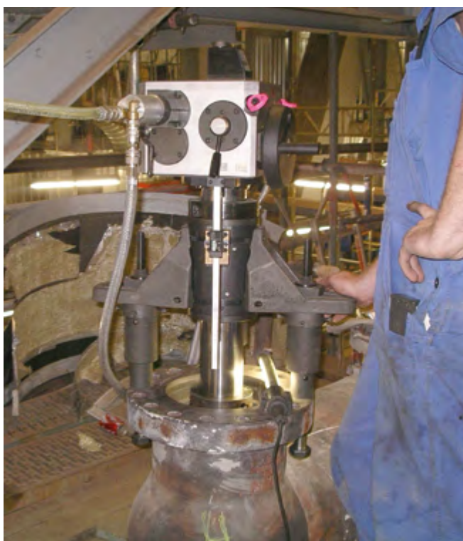
Lavorazione di una valvola di sicurezza in loco con MD
